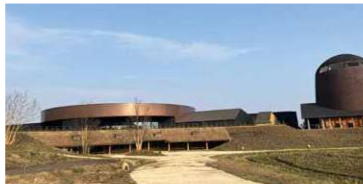
2023年1月11日にオープンした新施設「ラ コリーナ近江八幡 パームファクトリー」にガス工事と供給をさせていただいています。
